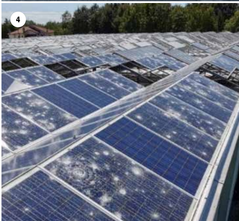
Esempi di danni al costruito osservati in regione a seguito del maltempo di luglio 2023: (1)-(2) tetti scoperchiati e (3)-(4) serre e pannelli fotovoltaici danneggiati dalla grandine (foto (3)-(4) gentilmente fornite da © Società Agricola Paulitti & C. s.s..)
